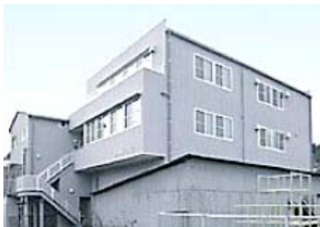
尾道工場（広島県尾道市）
