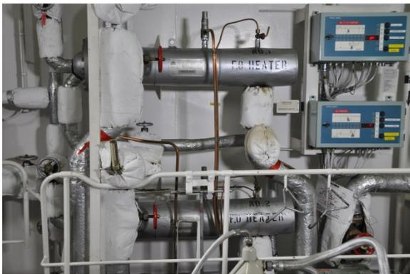
燃料油加熱器（主機関で重油を加熱し、適正粘度に調整される）
