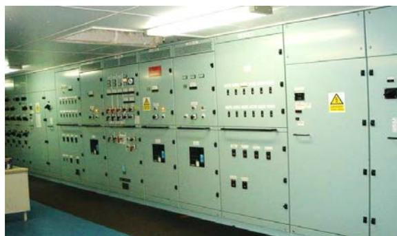
主配電盤及び給電盤（機関制御室内）
